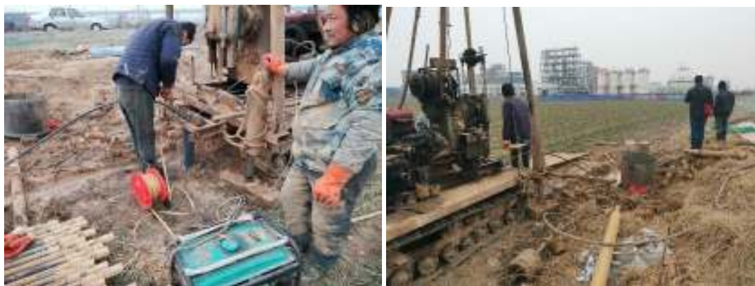
图 5.4-6 厂区附近孔抽水试验照片
